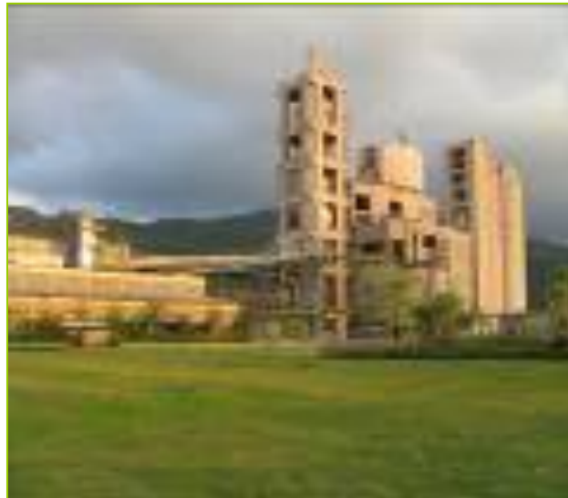
Foto 2: Planta de Cemento Andino.
