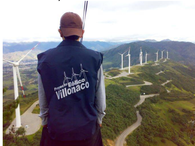
Figura 1.13: Fotografía del Parque Eólico Villonaco Loja - Ecuador
