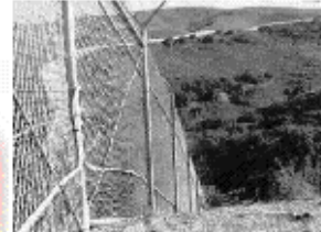
PROTECCION DE PERIMETROS CON SENSORES
