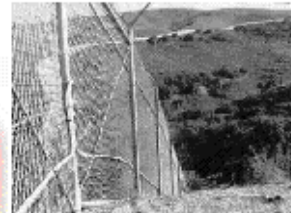
PROTECCION DE PERIMETROS CON SENSORES
